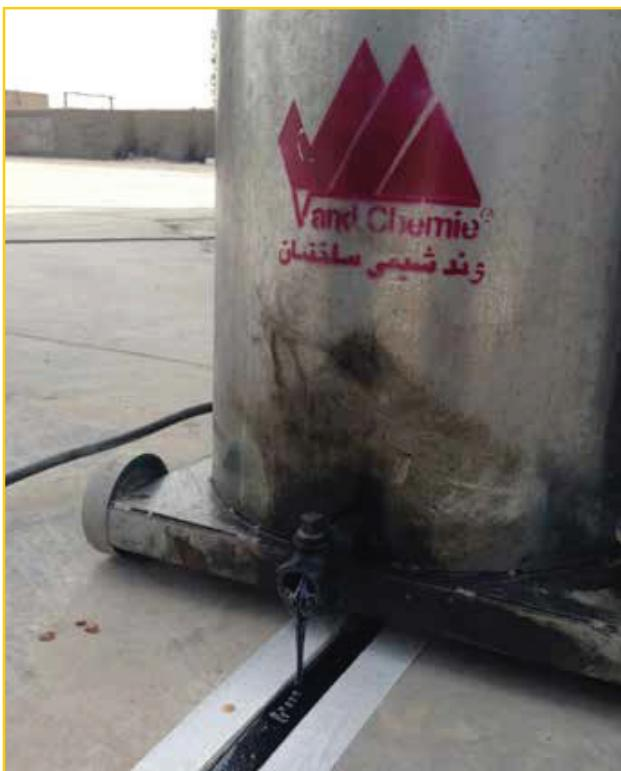
درز گیری است بر پایه ترکیبی از رزینهای سنتیک و بیتومن اصلاح شده با پلیمر که بصورت گرم بکار می‌رود. این ماده مخصوص درزهای انساط افقی و درزهای ساختمانی است.
